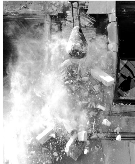
slopen met een sloopkogel
